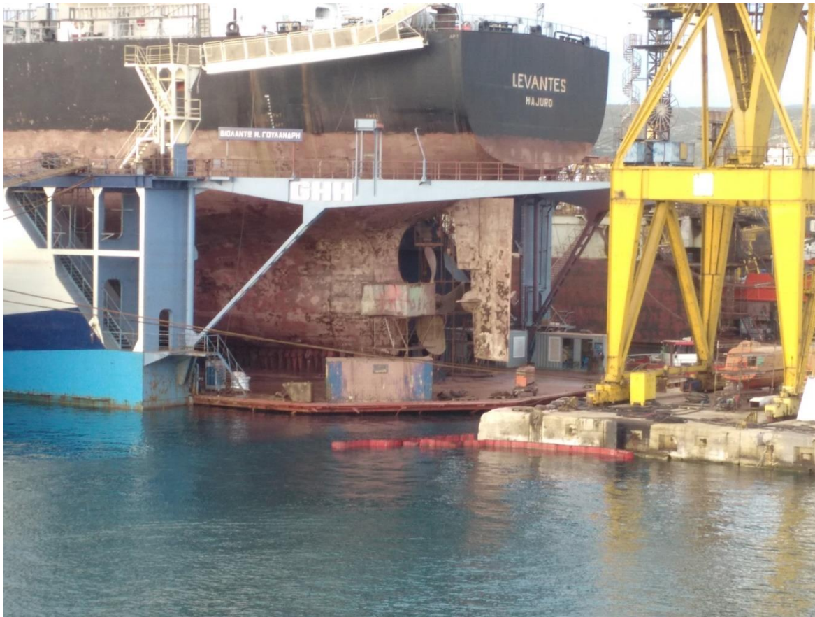
Πηγή φωτογραφίας Π.Π.Π.Σ. - Σκουριά, υφαλοχρώματα και βιολογικό φορτίο που αφαιρούνται
