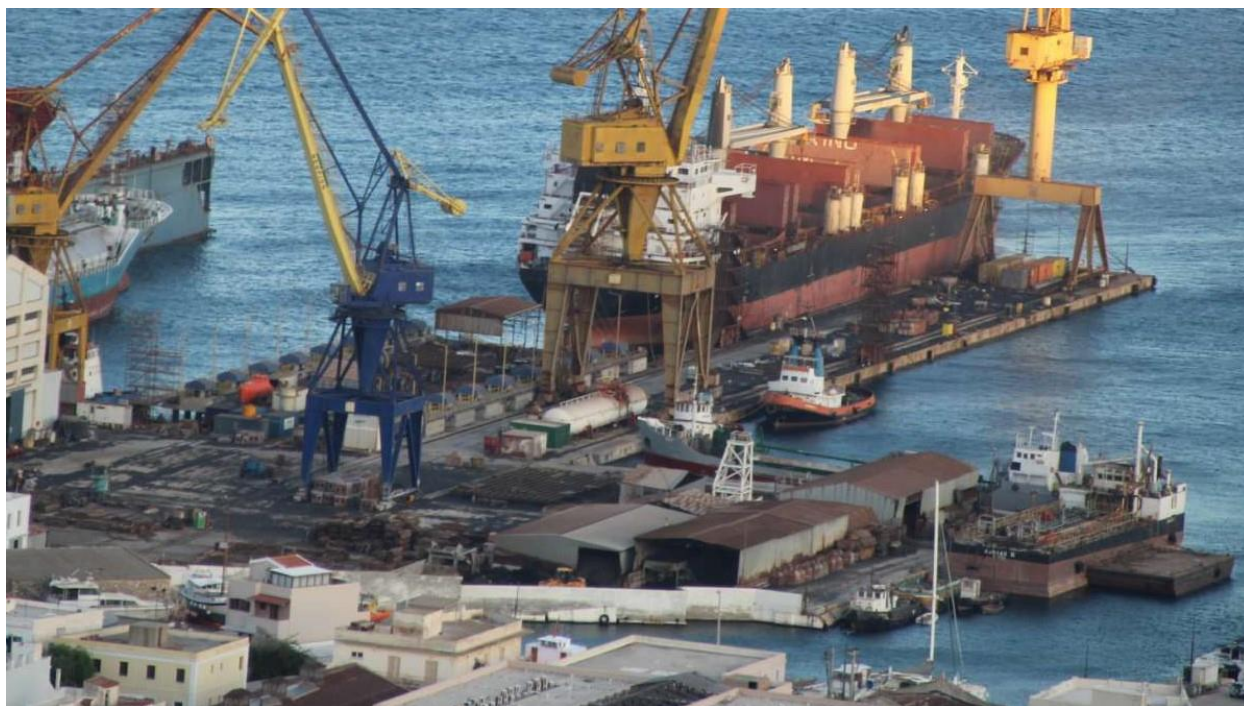
Πηγή φωτογραφίας: Π.Π.Π.Σ. - Τάπητας αποβλήτων αμμοβολής σε όλο το χώρο.
