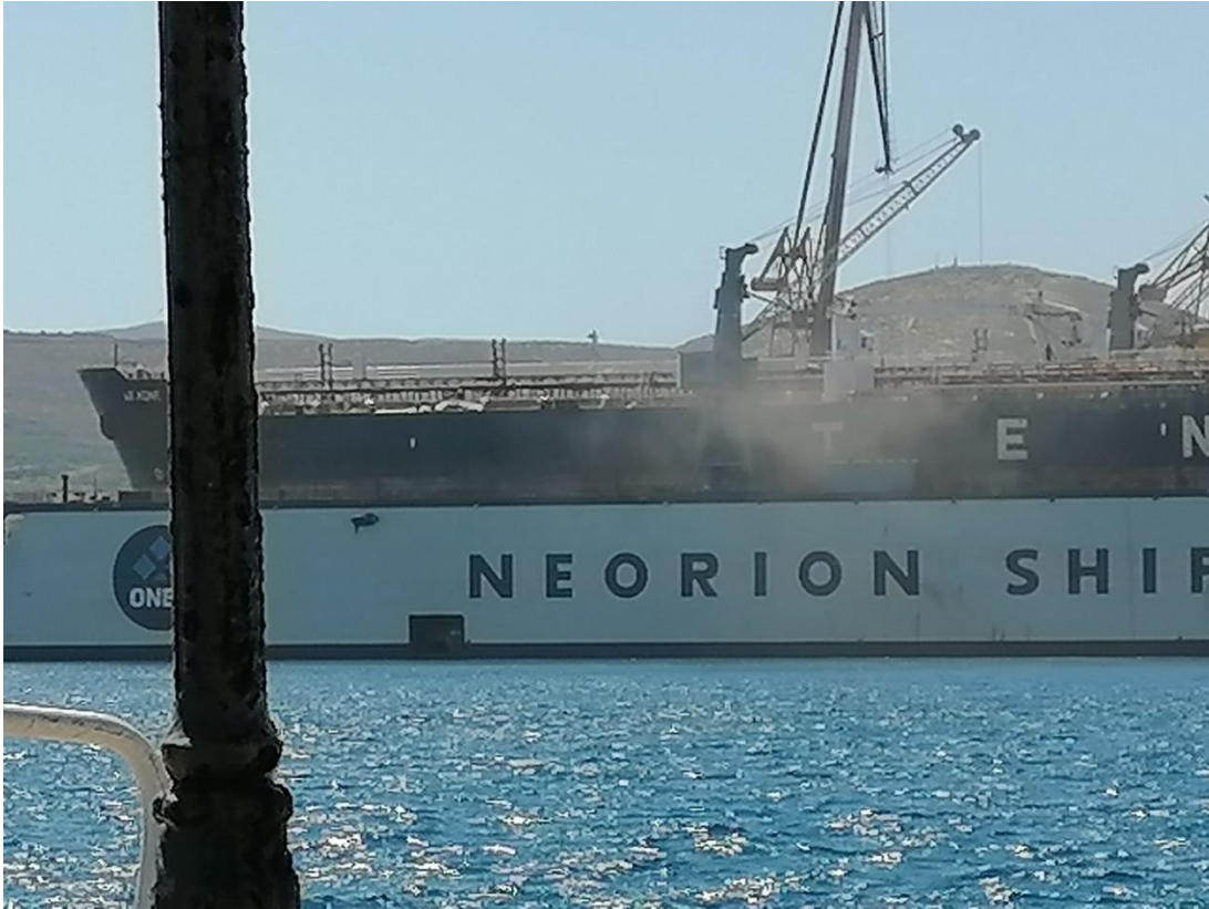
Πηγή φωτογραφιών Π.Π.Π.Σ. - Σκόνη αμμοβολής διασπείρεται σε θάλασσα και αέρα
