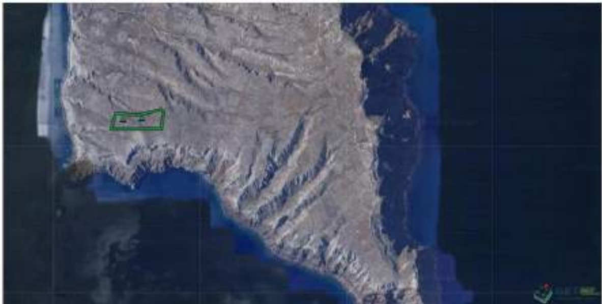
Εικόνα 88: Αιολικός σταθμός Θηρασίας (Πηγή: ΡΑΕ)
